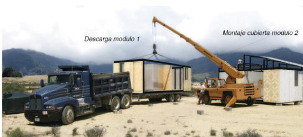
fig. 2 Montaje modulos in situ
